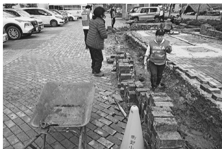
小学校の浄化槽修繕作業
