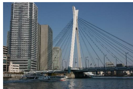
隅田川/中央大橋(下流側から)
