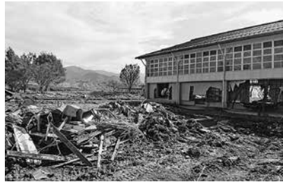
被災直後の長沼体育館
