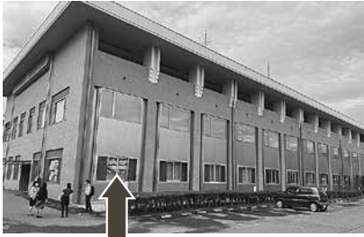
3回移転し、現在は豊野町役場1階にある 「まちの縁側ぬくぬく亭」
