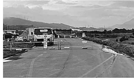
いまだ工事中の千曲川決壊場所
