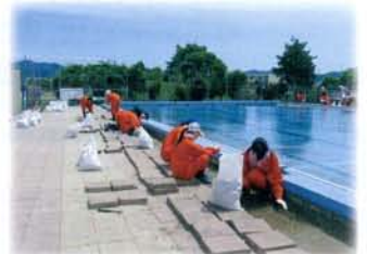
万石浦小学校プールの補修ワーク(7月) 地盤沈下による凹凸の危険箇所を補修
