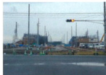
石巻市蛇田に建設中の公営住宅(2014年10月)
